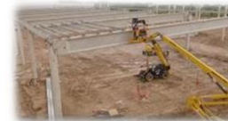
↑ 建屋工事の状況（アルゼンチン）
