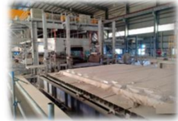
↑ 設備据付工事の状況（ベトナム）
